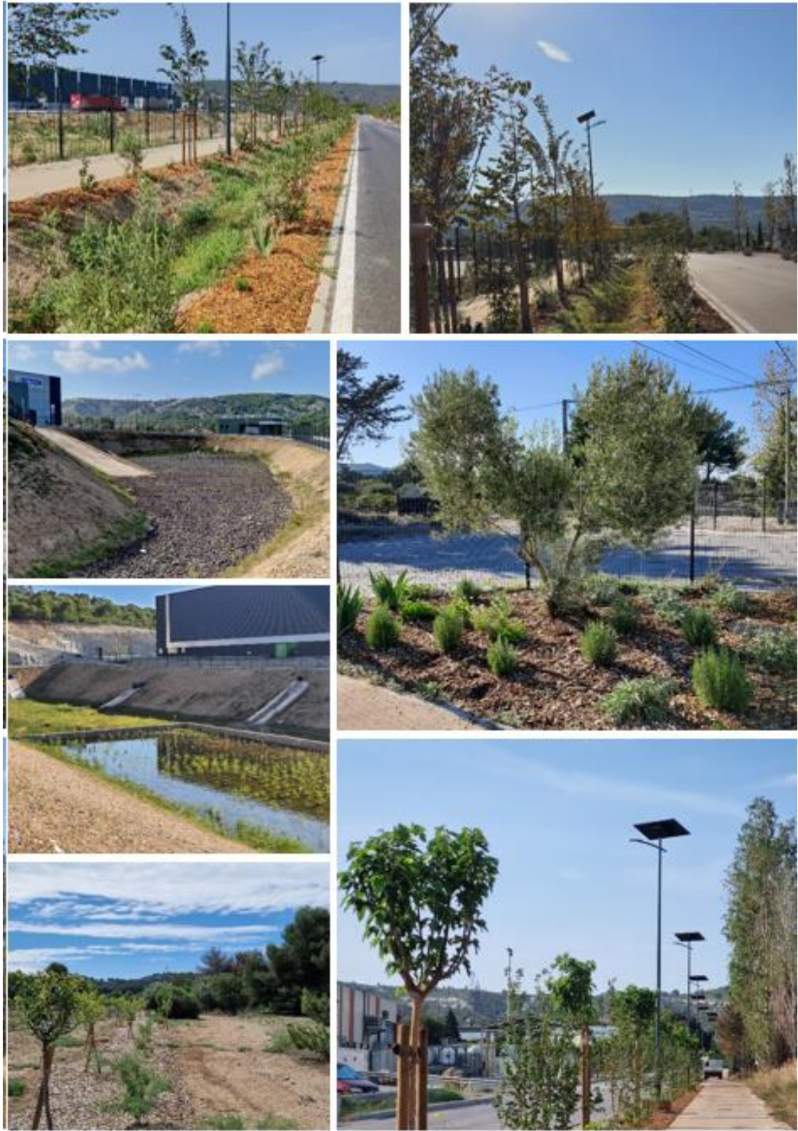
Différentes photographies des aménagements paysagers réalisés
