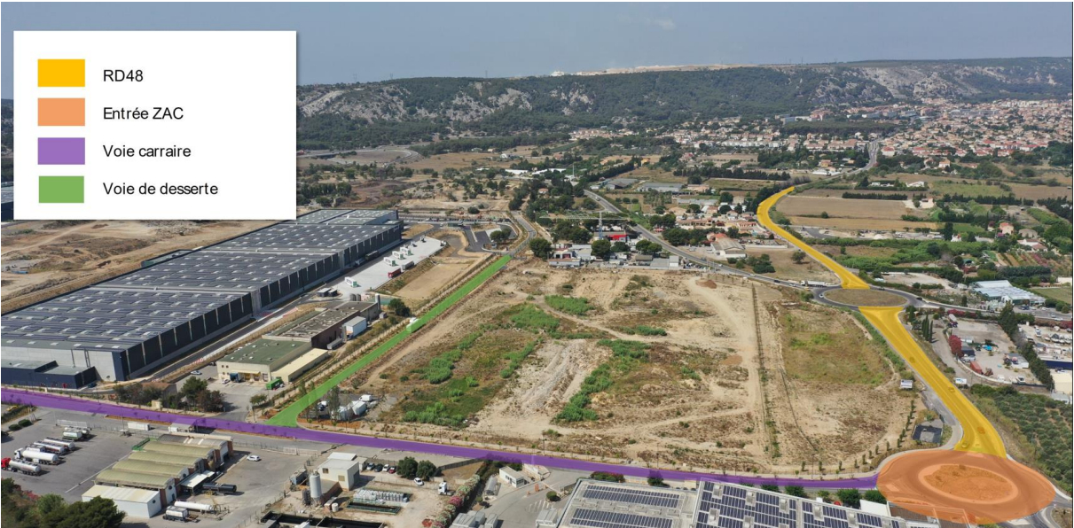
Vue aérienne (juillet 2023) : rond-point sur la RD48a, Voie Carraire de l'Aiguille (axe Nord/Sud)
