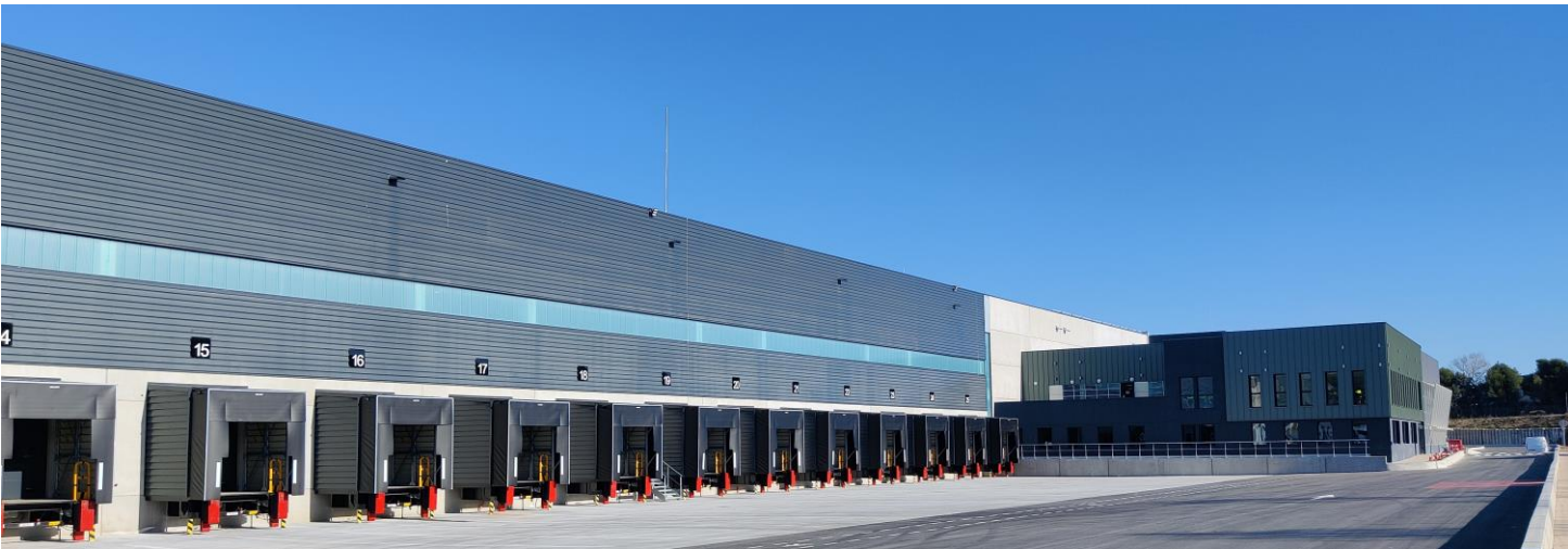
Bâtiment D -façade Sud
