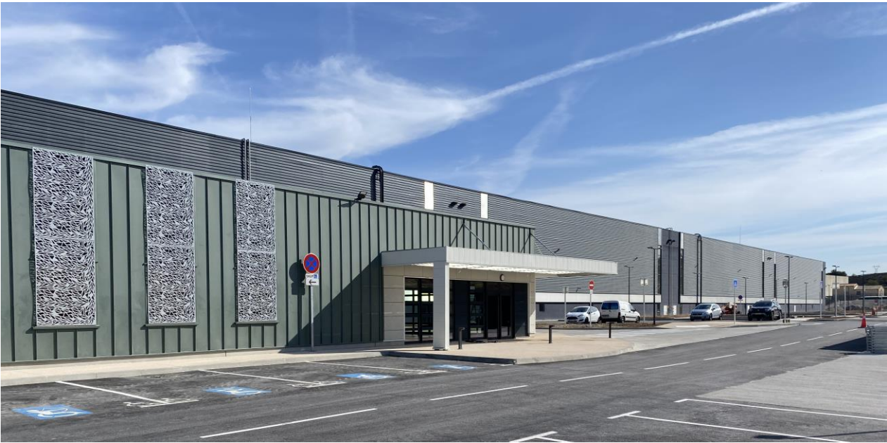
Vue sur les bureaux du lot H -façade Sud
