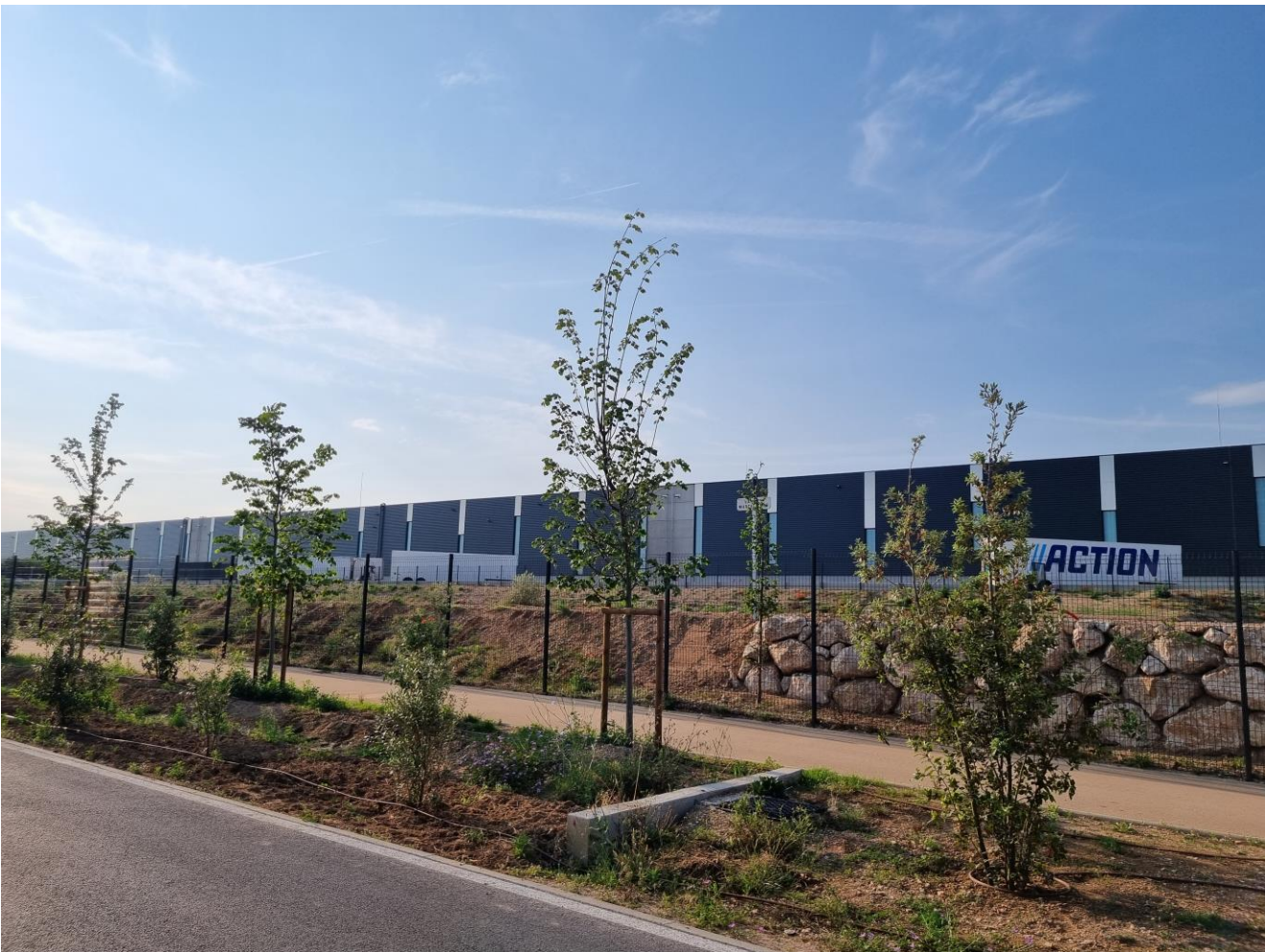
Vue sur la façade Nord du Bâtiment D -depuis la voie de desserte
